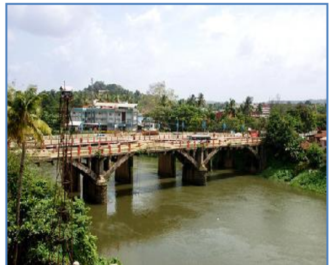
Fig- 1: Muvattupuzha Bridge
