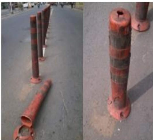
Fig -2.5.: Flexible PU Barriers
