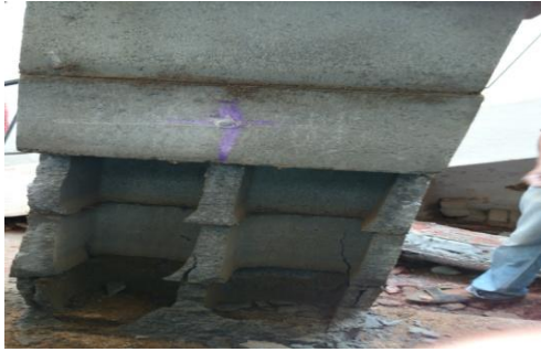
Fig 3(d) failure pattern
