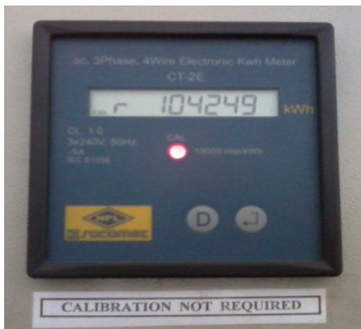
Fig -1: Energy Meter
